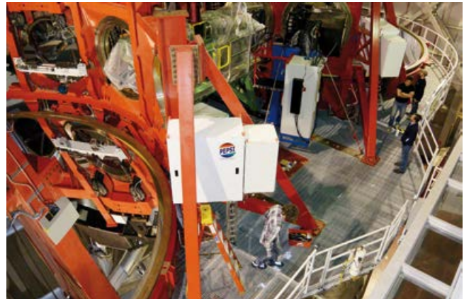
Fig. 5: Die zwei PEPSI PFUs (weiße Kästen, die zu den jeweiligen Hauptspiegeln gerichtet sind) werden am LBT montiert. The two PEPSI PFUs (the white boxes facing the respective primary mirrors) are being installed at the LBT.
