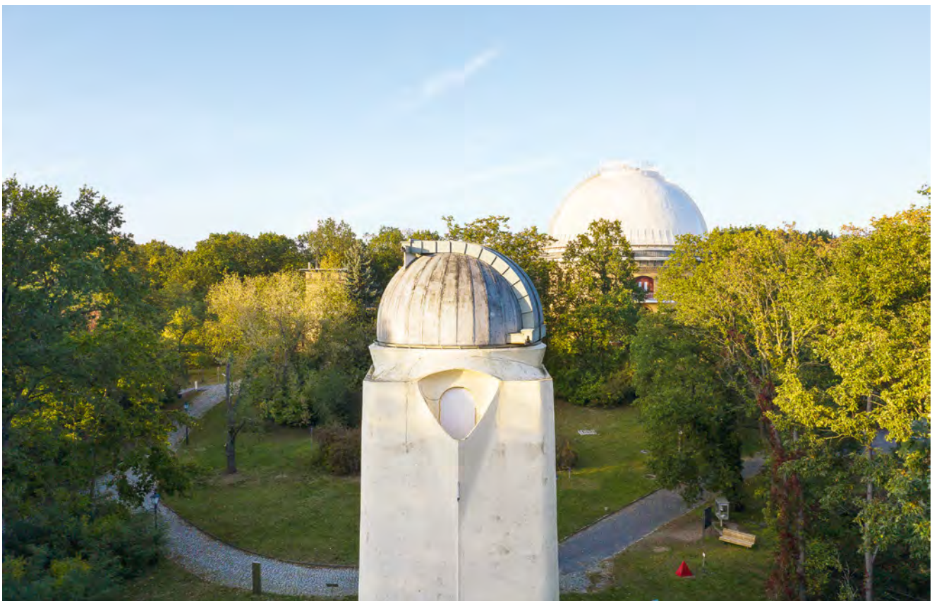
Die Kuppeln der historischen Teleskope Einsteinurm und Großer Refraktor auf dem Telegrafenberg. The domes of the historical telescopes Einstein Tower and Great Refractor on Telegrafenberg. (Credit: dronearchive.org)
