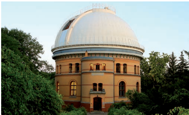
Das von Architekt Paul Spieker entworfene Kuppelgebäude des Großen Refraktors im Abendlicht.
