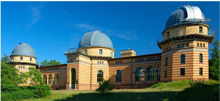
Bild 13. Hauptgebäude (Südseite) des Astrophysikalischen Observatoriums. Die Backsteine stammen aus regionalen Ziegeleien, Grundmauern und Treppen aus Sandstein von Wefensleben und die Verkleidung aus Siegersdorf bei Bunzlau. Mittelkuppel 10 m. Oben: Originalzustand mit eingebautem Heliograph; unten: mit nachträglich geschaffenem Südgang sowie verglasten Wandelgängen. Photos: Architekturmuseum Berlin, R. Arlt.
