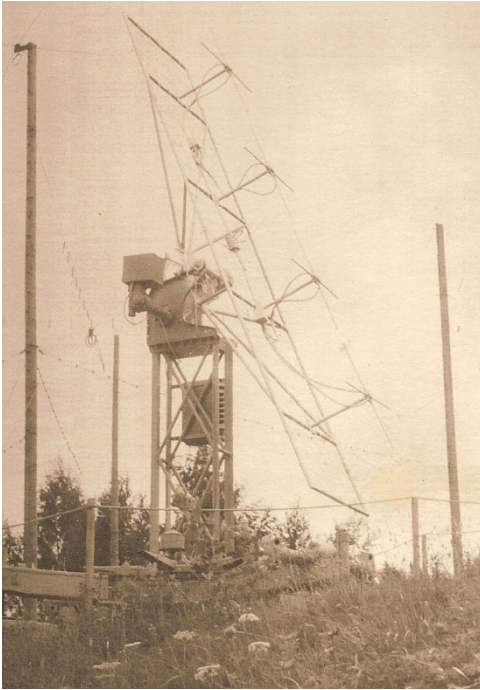
Bild 48. Empfangsantenne (1958) zur plasmaphysikalischen Untersuchung von Satellitensignalen, zur Nachführung auf einer Flak-Lafette montiert. Archiv G. Entzian.
