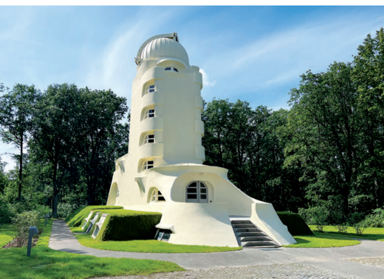
▲ Der Einsteinturm nach der Sanierung im Jahr 2023
