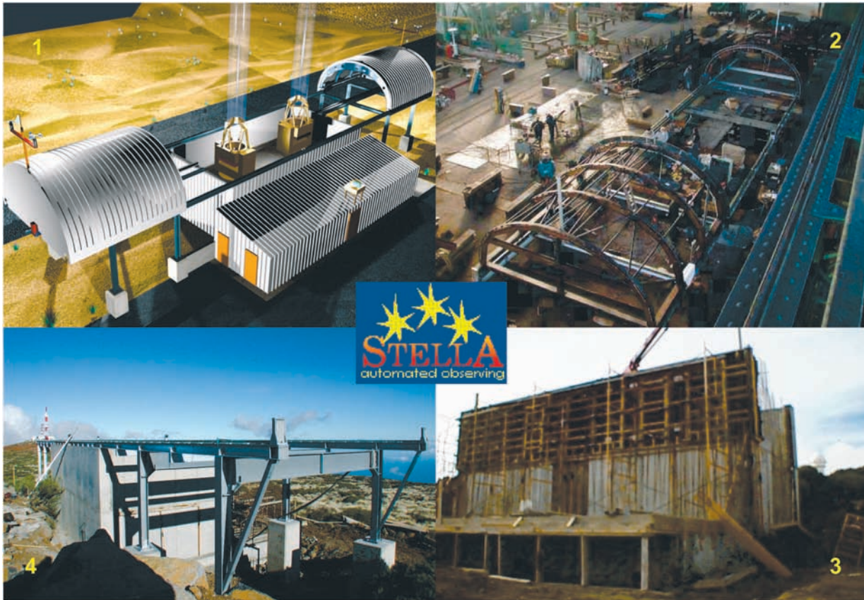
Abbildung 93: Baufortschritt des STELLA Observatoriums. 1 3D-CAD design mit geöffnetem Dach. STELLA-I wird das linke Teleskop sein, STELLA-II das rechte. Das flache Zusatzgebäude beinhaltet einen thermisch isolierten Spektrografenraum, einen großen Elektronik- und Computerraum, sowie zwei kleinere Versorgungsräume. 2 In der Montagehalle in Brandenburg. 3 und 4 Baufortschritt in Teneriffa im Dezember 2001 (siehe dazu www.aip.de/stella ).
