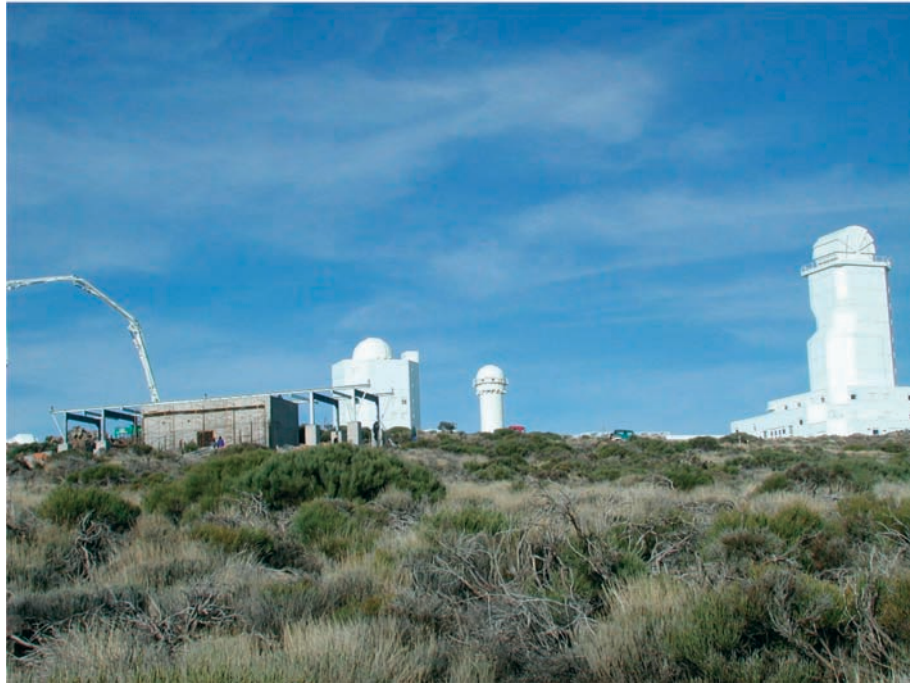
Abbildung 5: Konstruktion der STELLA Sternwarte. Das Bild zeigt den Fortgang der Bauarbeiten am 2400m hohen Standort am Teide Observatorium auf der Insel Teneriffa im Dezember 2001. Das STELLA Gebäude ist ganz links im Bild (mit Betonkran). Im Hintergrund sind von rechts nach links das Vakuum Turm Teleskop, das Newton Teleskop und der Gregory Turm zu sehen. Letzterer wird anstelle des 45 cm Gregory Teleskops das neue 1.5m Sonnenteleskop GREGOR aufnehmen.
