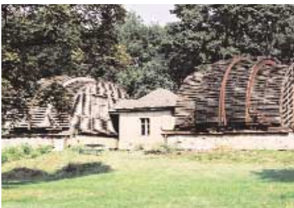
Die Meridiankreisgebäude B10/B11 vor Beginn der Rekonstruktion. Das Gebäude B9 steht rechts im Hintergrund
