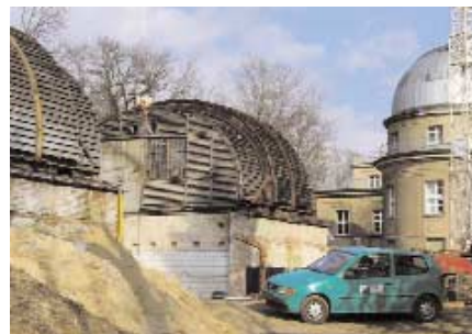
Die Meridiankreisgebäude B10/B11 in einem frühen Stadium der Arbeit. Im Hintergrund das Hauptgebäude B7
