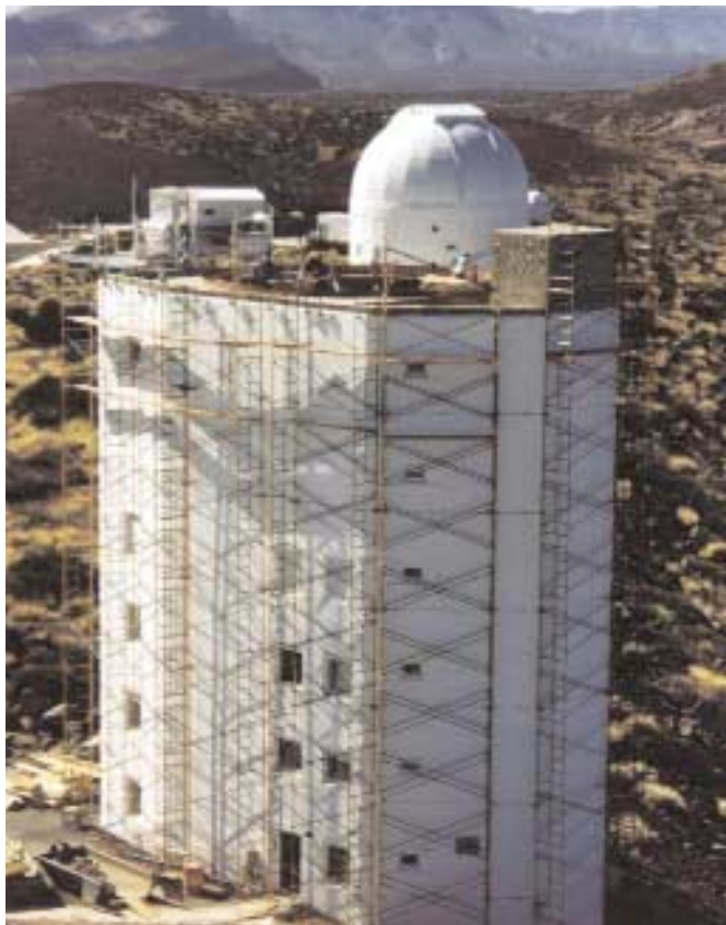
Baustelle GREGOR-Gebäude. Die alte Kuppel ist entfernt worden, der Kuppelkranz für die neue faltbare Kuppel wird gerade gefertigt (die im Bild sichtbare Kuppel gehört zu einem anderen Gebäude im Hintergrund).
