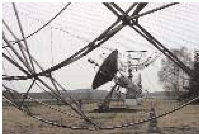
Ausschnitt des Antennenfeldes in Trensdorf
